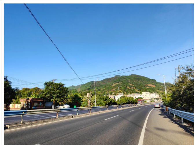
沿线交通设施进行了系统性升级改造
