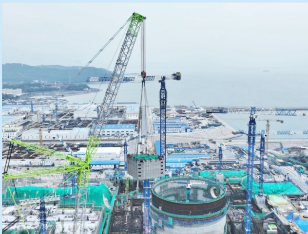
漳州核电4号机组非能动堆腔注水箱模块一成功吊装就位
