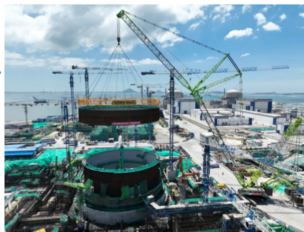
漳州核电4号机组反应堆厂房钢衬里模块四吊装成功
