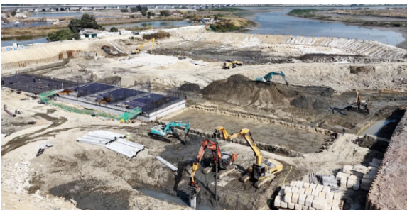
项目现场，挖掘机作业中
