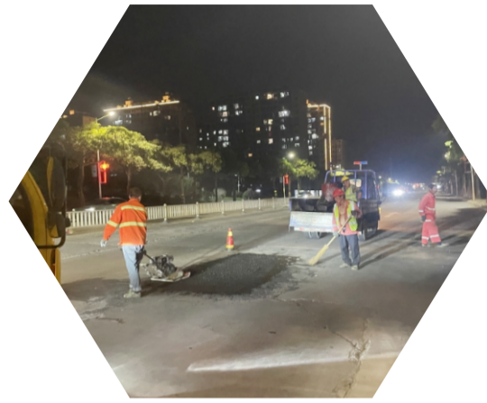
工作人员修补破损路面
