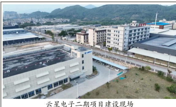
云星电子二期项目建设现场
