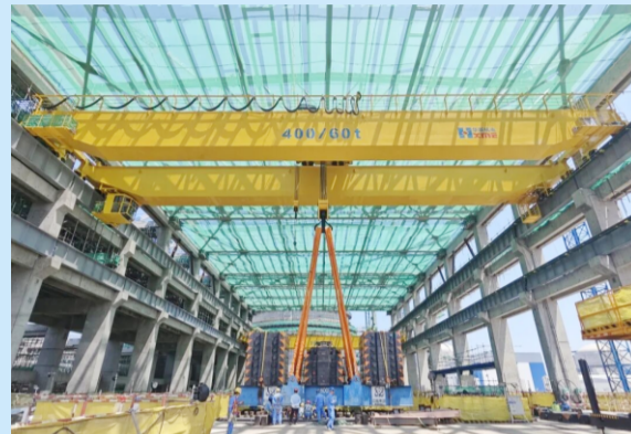
漳州核电3号机组汽轮机厂房两台主行车载荷试验顺利完成
